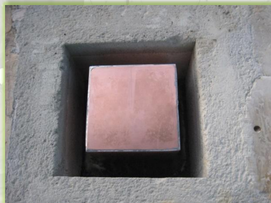
Měděná schránka v základu obsahuje aktuality z dění v obci
